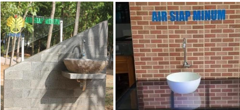
Gambar 9.4. Air Kran Siap Minum di UNNES
