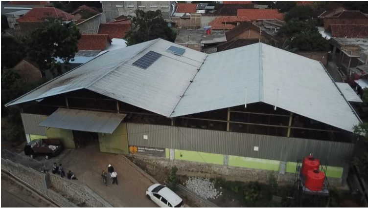
Gambar 9.7. Bangunan TPST UNNES
